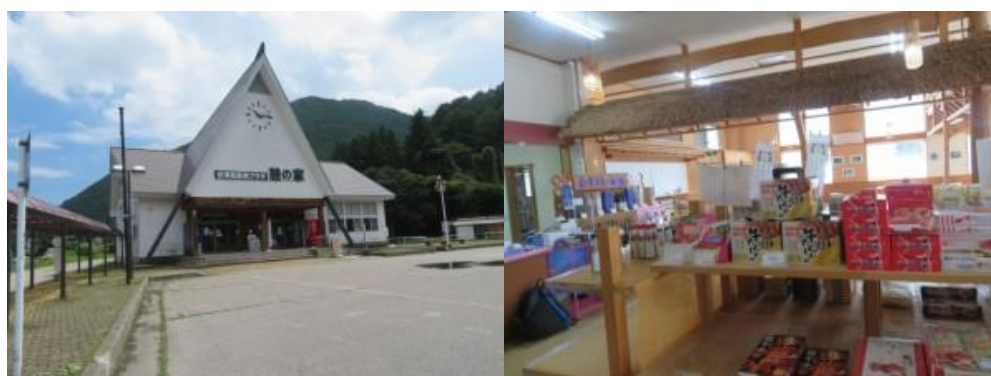
※憩の家（会津高原尾瀬口駅への玄関）
